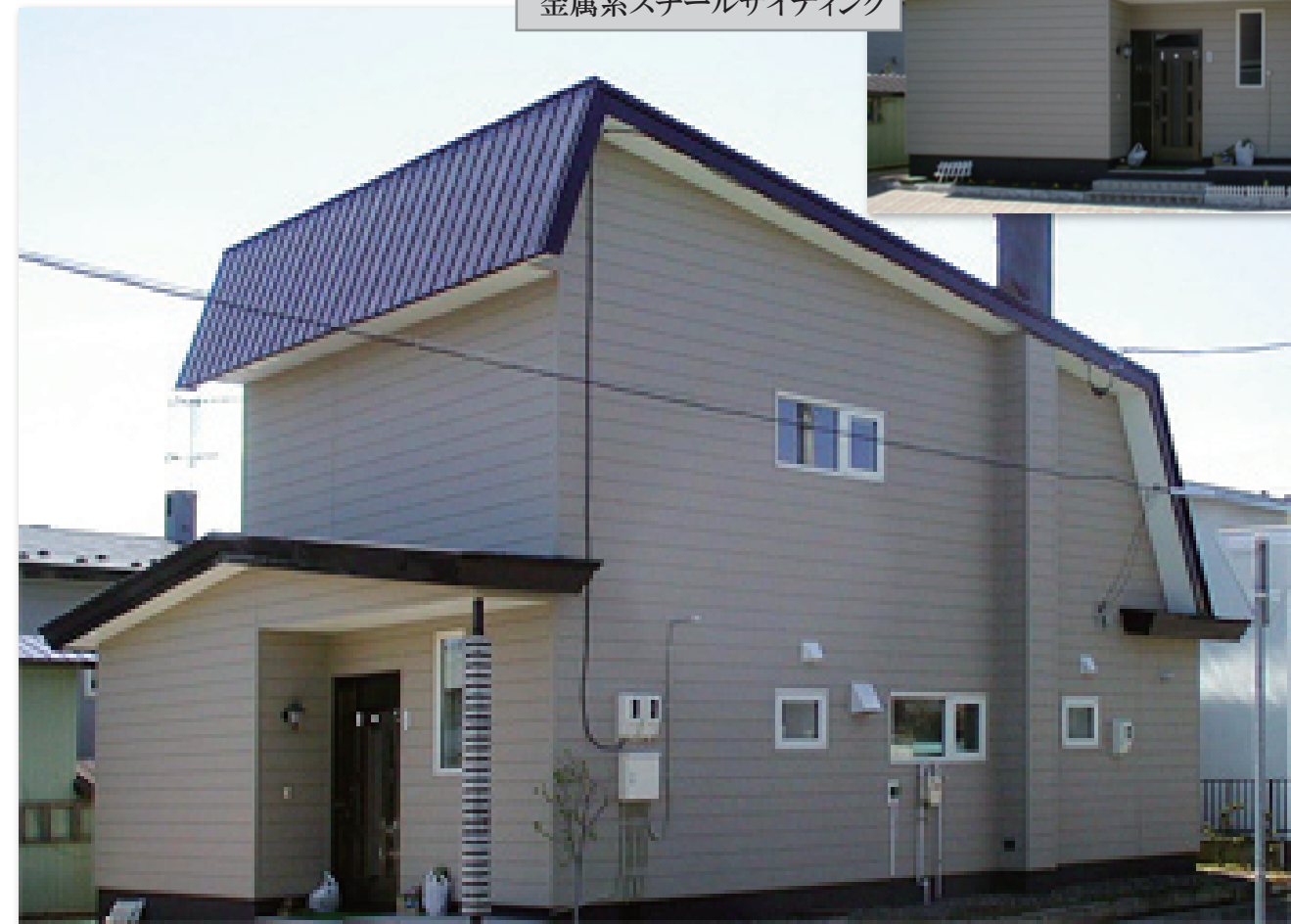
外壁サイディング 金属系スチールサイディング
